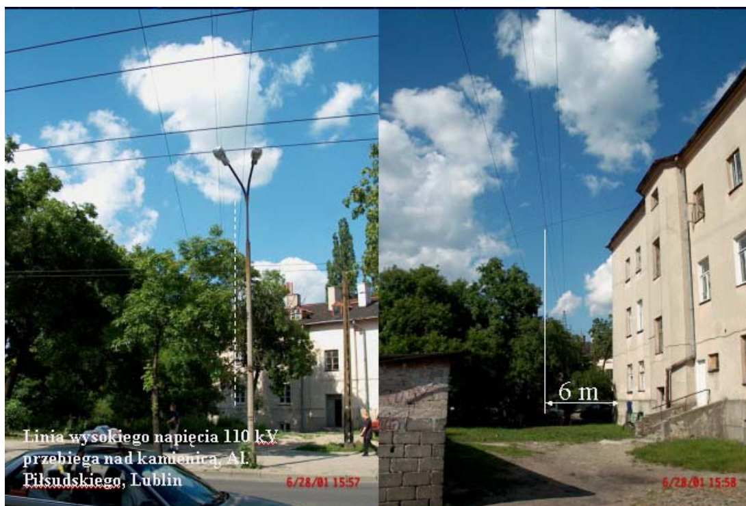
Rys. 8. Linia wysokiego napięcia przebiega w zaledwie odległości 6m od jednej z kamienic, oraz ponad dachem drugiej.
