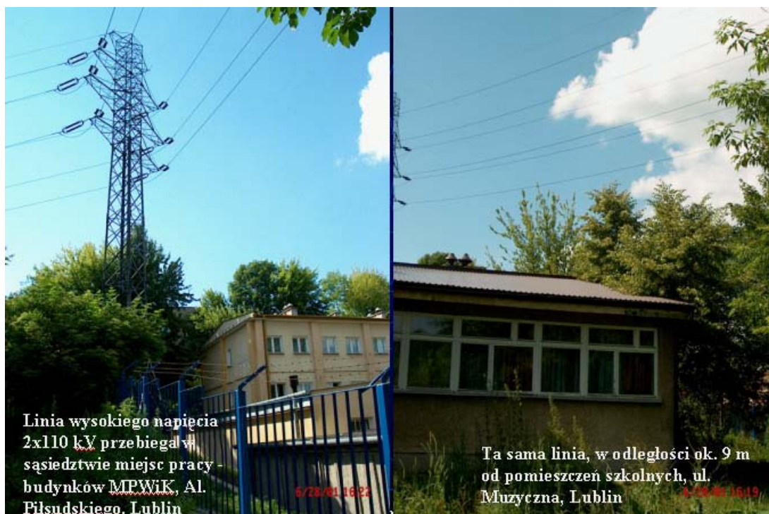
Rys. 7. Linia wysokiego napięcia w bezpośrednim sąsiedztwie miejsc pracy i pomieszczeń szkolnych.
