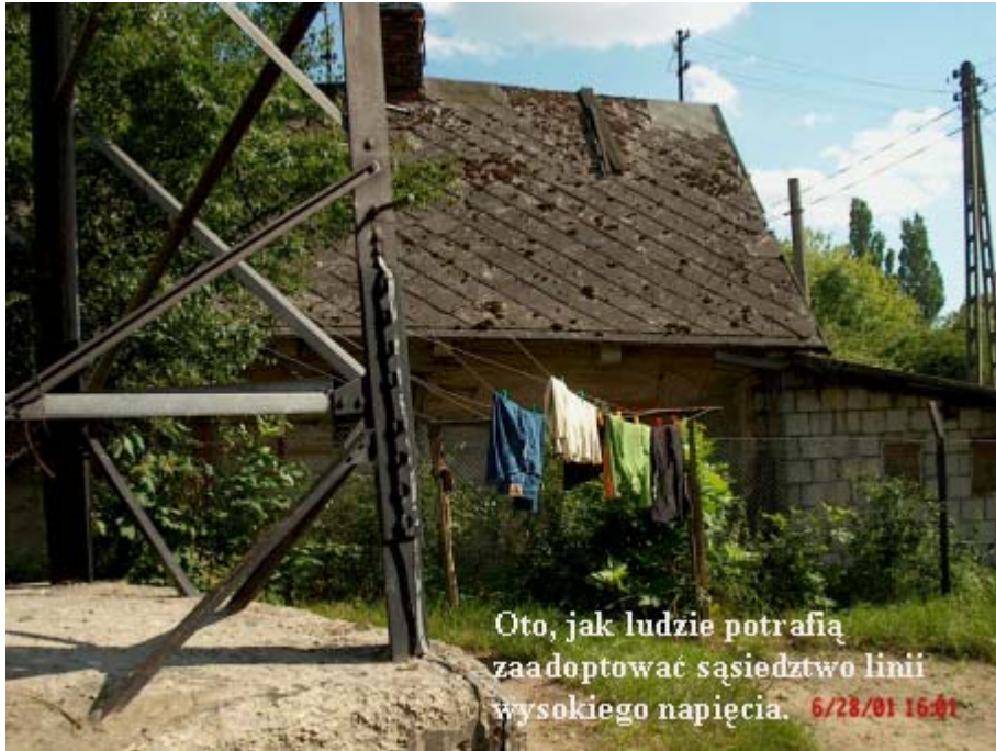
Rys. 9. Zdjęcie wskazujące jak bardzo duża jest nieświadomość niektórych grup społecznych na zagrożenia płynące z faktu przebywania w bezpośrednim sąsiedztwie linii wysokiego napięcia.
